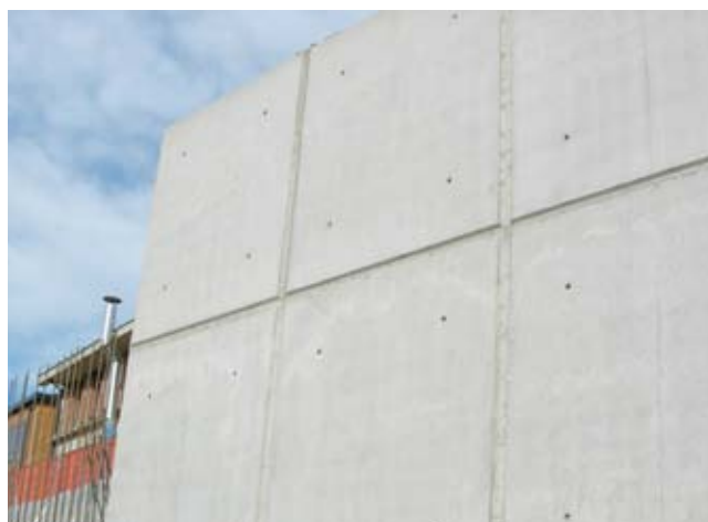
Nahoře: ošetřená betonová zeď
