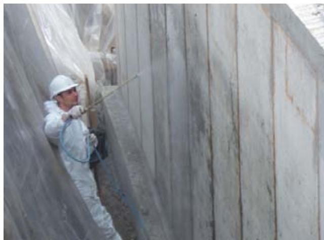
Nahoře: aplikace přípravku Vetrofluid® pomocí nízkotlakového postřikovače
